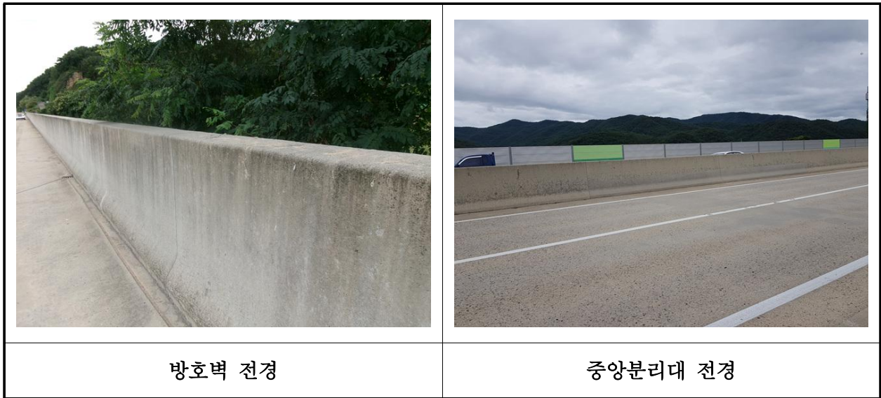
【사진 17.3.49】 방호벽 및 중양분리대 전경
