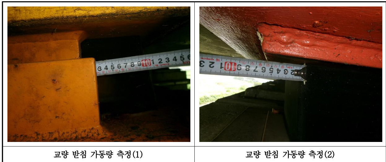
【사진 17.3.41】 교량받침 이동량 측정
