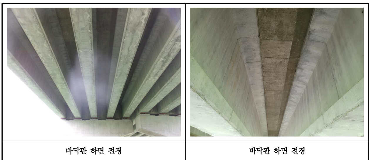
【사진 17.3.2】바닥판하면 전경
