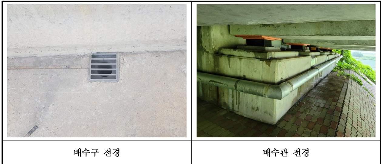
【사진 17.3.22】 배수시설 전경
