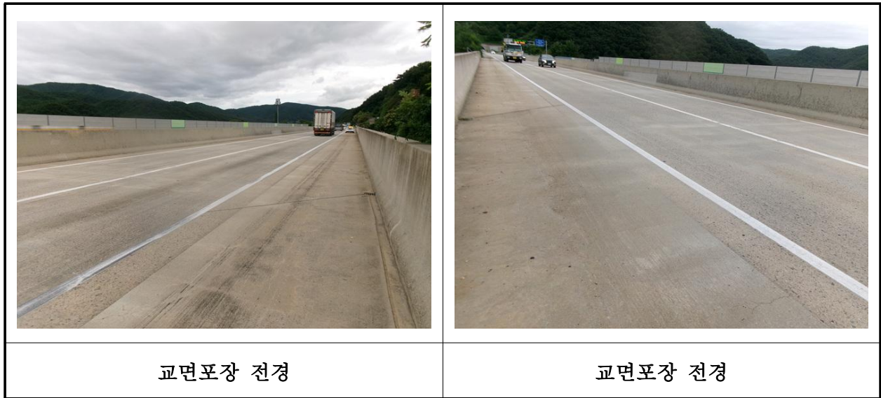
【사진 17.3.45】 교면포장 전경
