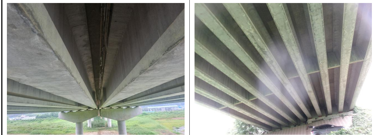
중분대 하면 상태양호
