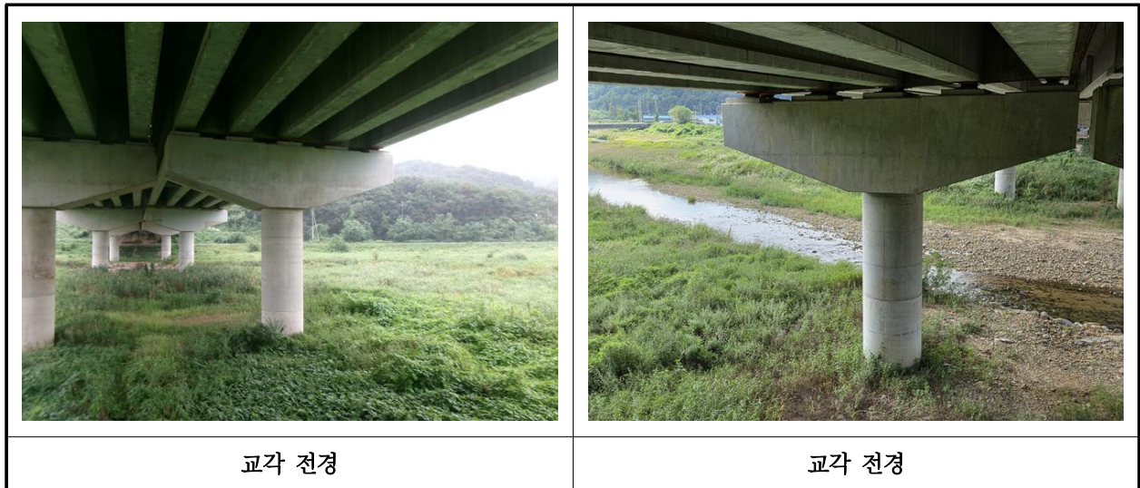
【사진 17.3.35】 교각 전경
