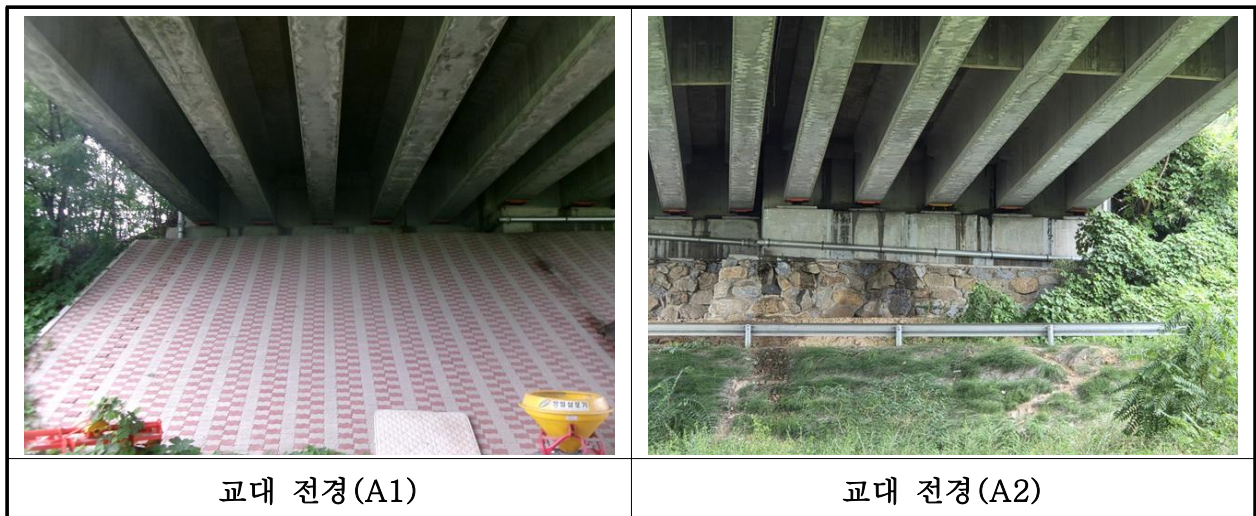
【사진 17.3.33】 교대 전경
