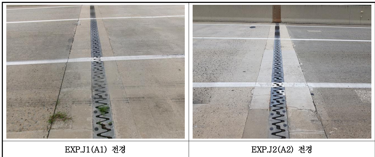
【사진 17.3.42】 신축이음장치 전경
