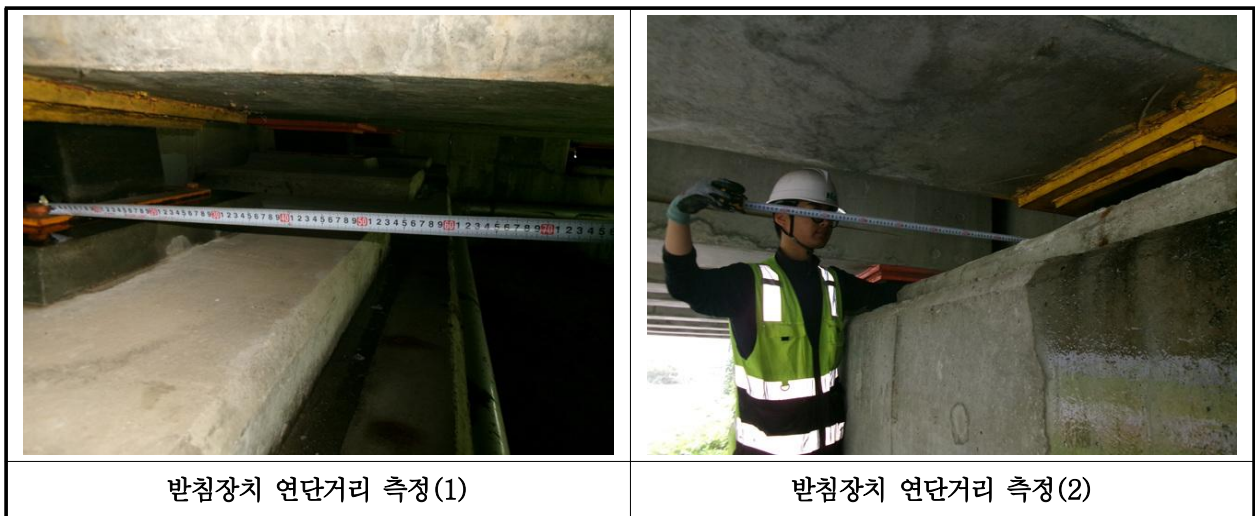
【사진 17.3.40】 교량받침장치 연단거리측정
