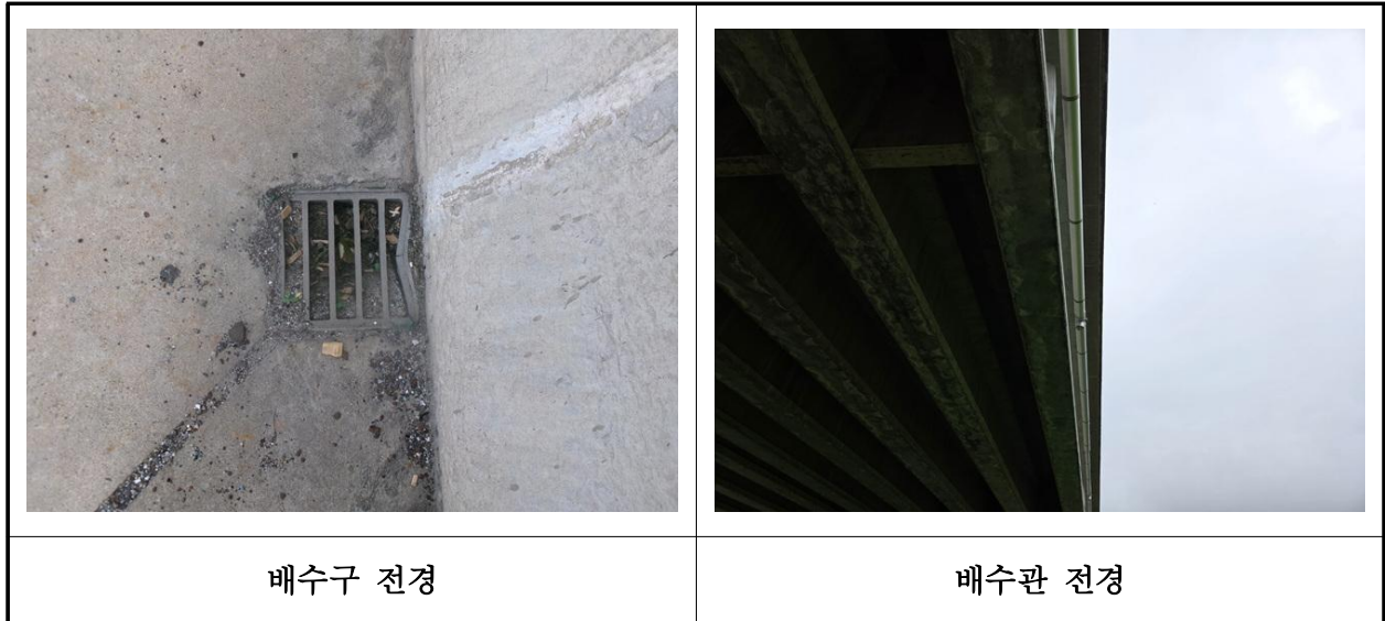
【사진 17.3.47】 배수시설 전경
