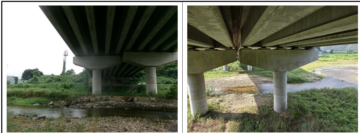
교각 코핑부 상태양호
