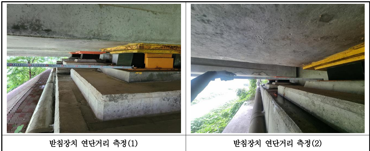
【사진 17.3.15】 교량받침장치 연단거리측정
