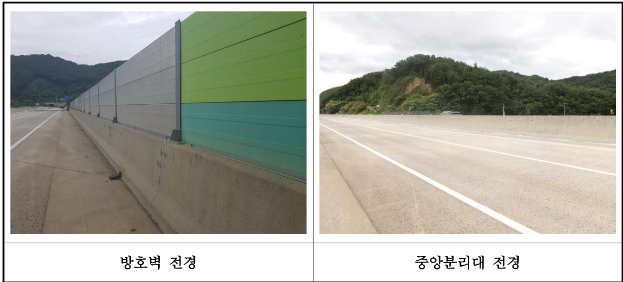
【사진 17.3.24】 방호벽 및 중앙분리대 전경
