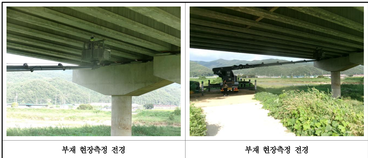
【사진 17.2.1】 부재 현장측정 전경
