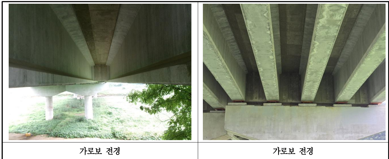
【사진 17.3.31】 가로보 전경
