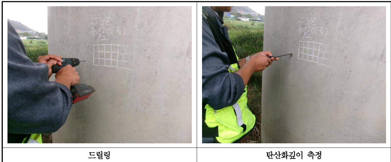
【사진 17.4.3】 탄산화 깊이 측정 현장사진
